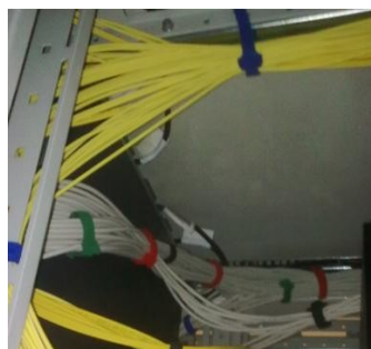
Figure 8: fixation évolutive à velcro
