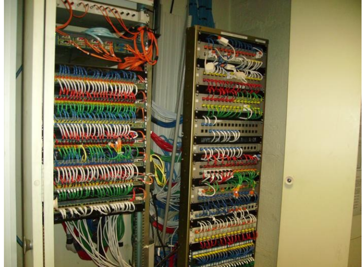
Figure 2: Le même local après réaménagement.
