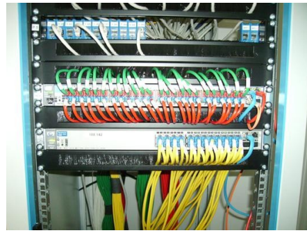
Figure 10: Passe-fils pour matériel actif 24 et 48 ports.
