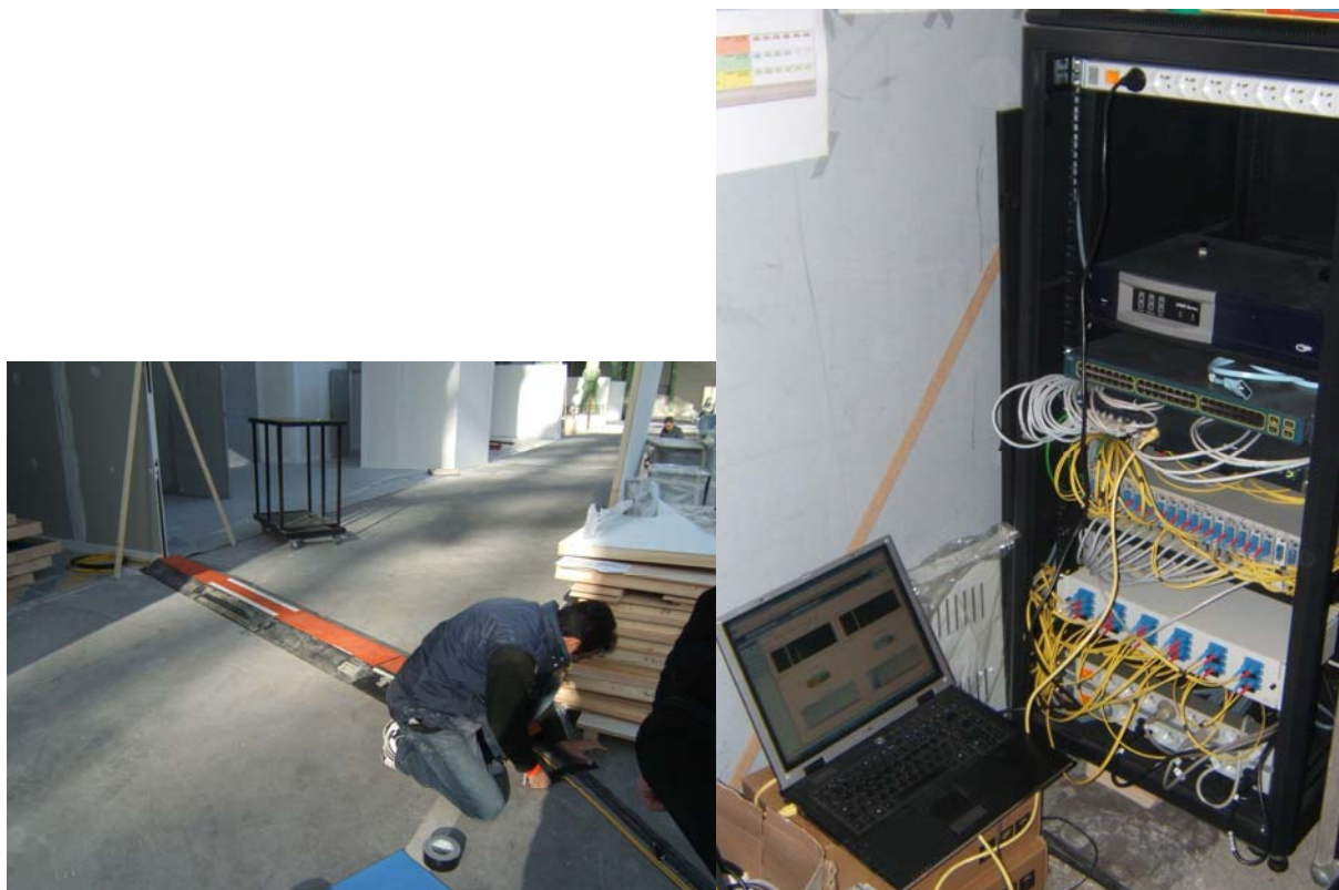
Figure 4 : Pose de câbles optiques dans le Grand Palais et Cœur du réseau de la Ville Européenne des Sciences
